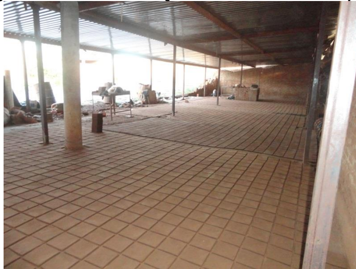
Figura 12. Patio de secado a resguardo de la lluvia mediante un tejabán
