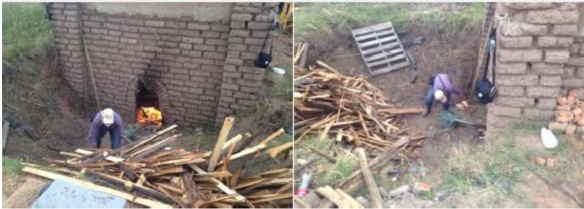
Figura 4. Uso de aireador y pruebas efectuadas en este Horno Fijo.
