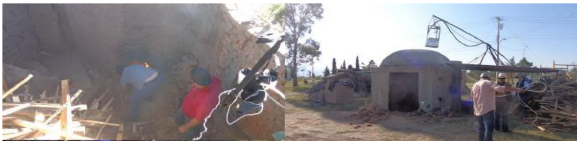
Fig 8, Aireador y equipos de medición utilizados en la medición del Horno-Ecológico-DGO Cortesía ABC-GAMATEK
