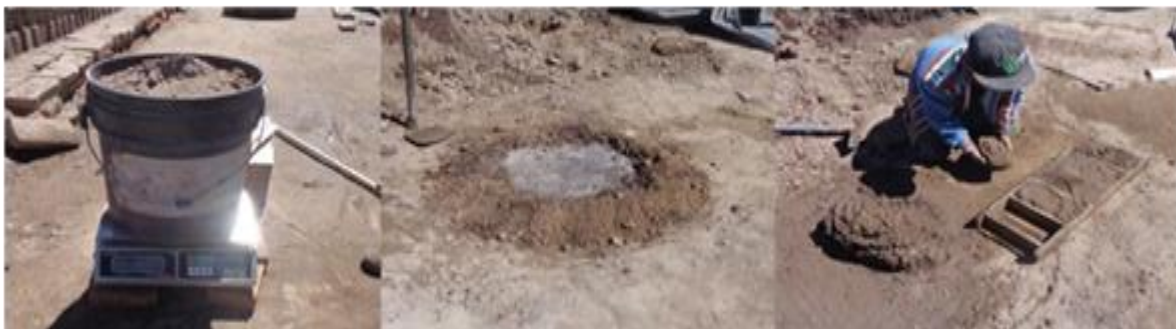
Figura 5. Uso de materiales y pruebas efectuadas en este Horno Fijo.
