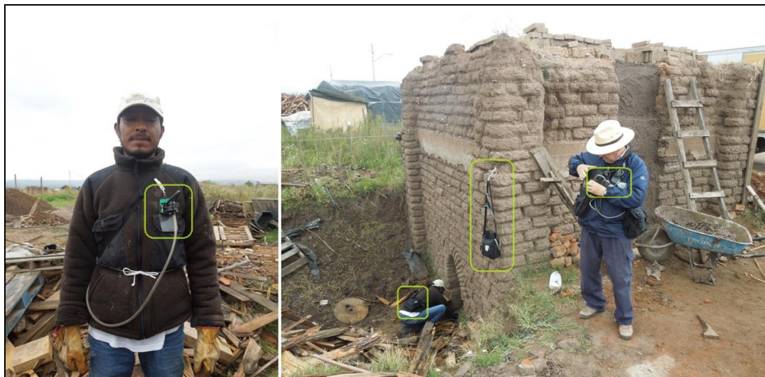
Figura 3-4 Identificación de los portadores (T-01 responsable de alimentar el horno y T-02 realiza actividades en las inmediaciones del horno) y sitio fijo (P.F.) donde se instalaron los equipos.
