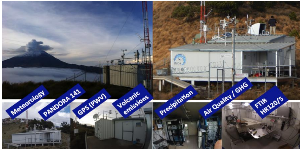
Figura 4. Infraestructura para la medición de las concentraciones de columna vertical de varios compuestos atmosféricos en el Observatorio Atmosférico de Alzomoni, ubicado a 4,000 m s.n.m. en el Parque Nacional Izta-Popo.
