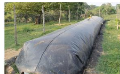
(4) Biodigestor tipo salchicha de flujo continuo
