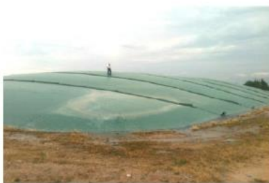
(3) Biodigestor de domo flotante
