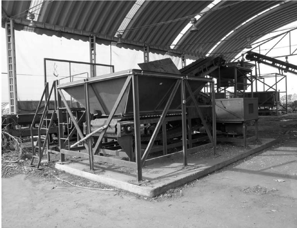
FIGURA 5. MAQUINARIA EN LA PLANTA DE COMPOSTAJE DE BORDO PONIENTE, DF.
